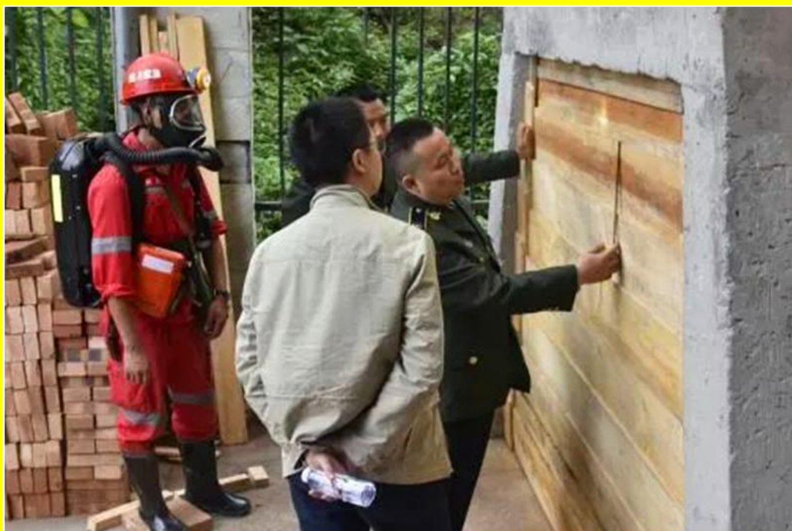
图为技术操作之建造木板密闭墙检查
