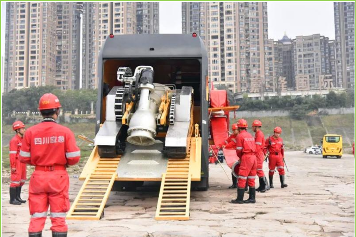
利用大流量排水车排水
